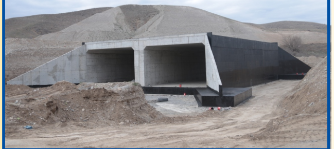
Zəngilan. Ağbənd avtomobil yolu. Yeraltı keçid
