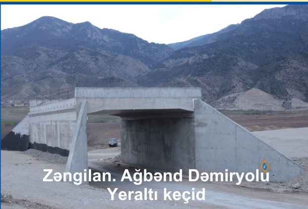
Zəngilan rayonu Mincivan şəhəri avtomobil yolu keçidi
